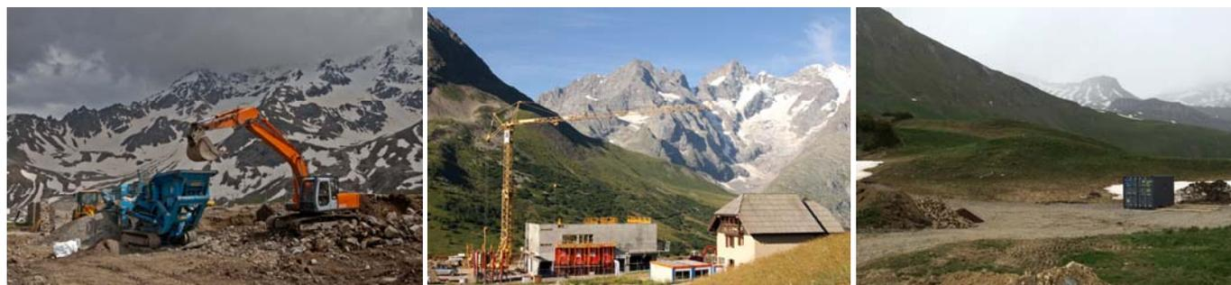
Fig. 24. Images des travaux de la démolition des ruines de l'hôtel PLM (à gauche), des débuts de la construction de la Galerie de l'alpe (au centre). Les matériaux issus du concassage de la ruine ont été utilisés pour réaliser un chemin d'accès à la zone expérimentale et pour réaliser une plateforme technique (image de droite) au-dessus du chalet-laboratoire, sur un terrain nouvellement acquis par l'université (bail emphytéotique avec la mairie de Villar d'Arène).
